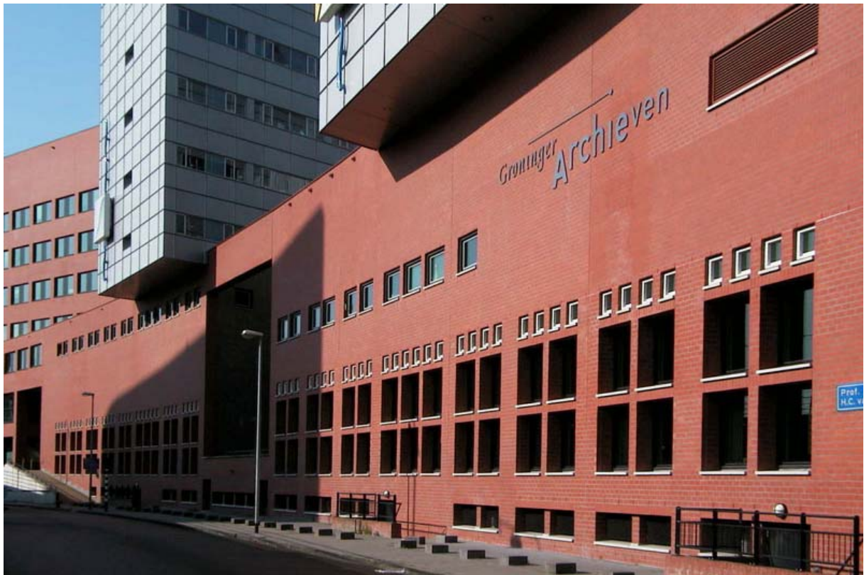
Groninger archieven, 1997, architect: B. Loerakker, foto: Rijksgebouwendienst
